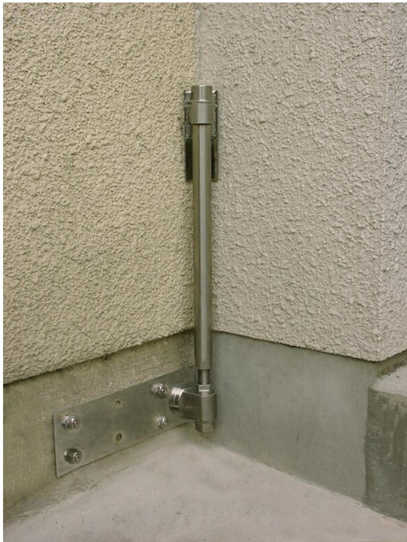
GDアンカーは後付けタイプのホールダウン金物で、屋外から壁を壊すことなく直接外部から施工できます。
